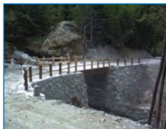
Les travaux au Pont d'Arsy.
