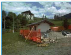
Les travaux des bains du camping sont démarrés.
