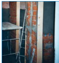
Lavori in canonica.
